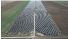
Scurtu Mare PV Plant 56 MW
